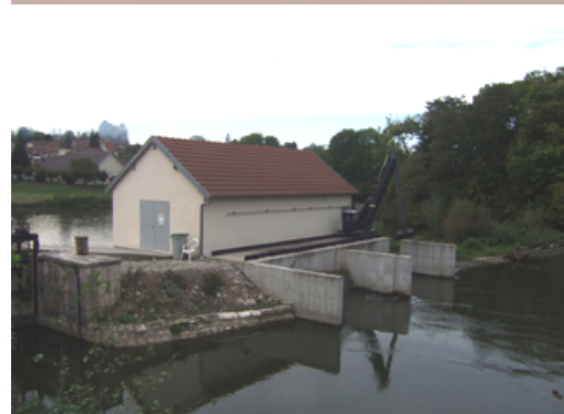
Deux anciens moulins transformés en centrales hydroélectriques à Port-sur-Saône (en haut, 220kW) et à Scey-sur-Saône (en bas, 320kW)
