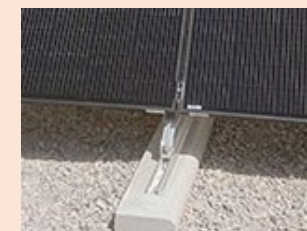
Poteaux béton (type clôture)
