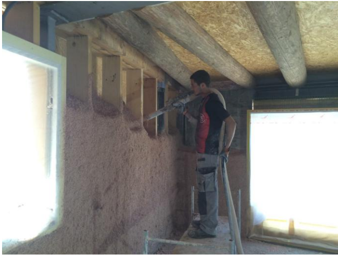
Application par projection mécanique
