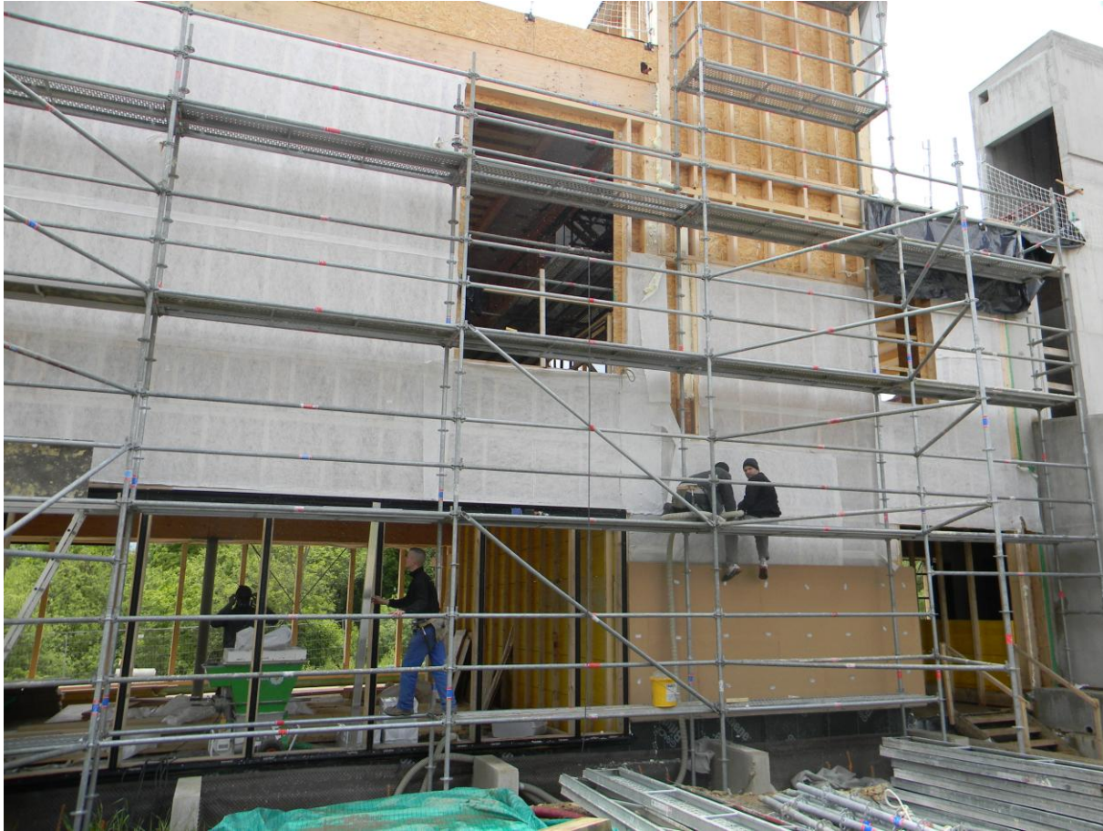
Construction siège Pôle énergie (70)
