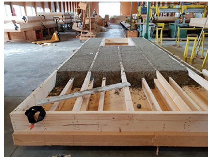
Préfabrication béton de chanvre
