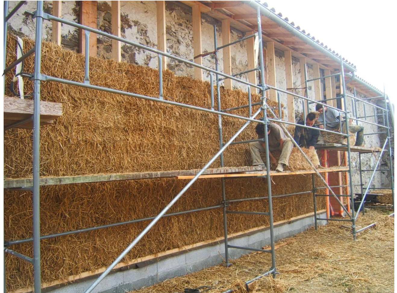
Pose de la paille à même le mur existant
